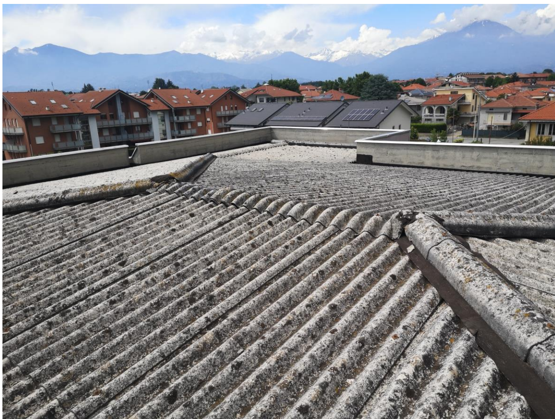
Foto 4 – Copertura esistente con lastre di cemento amianto
